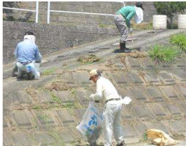
(炎天下の中、コンクリートの隙間からスキの根を取り出す作業をする)
